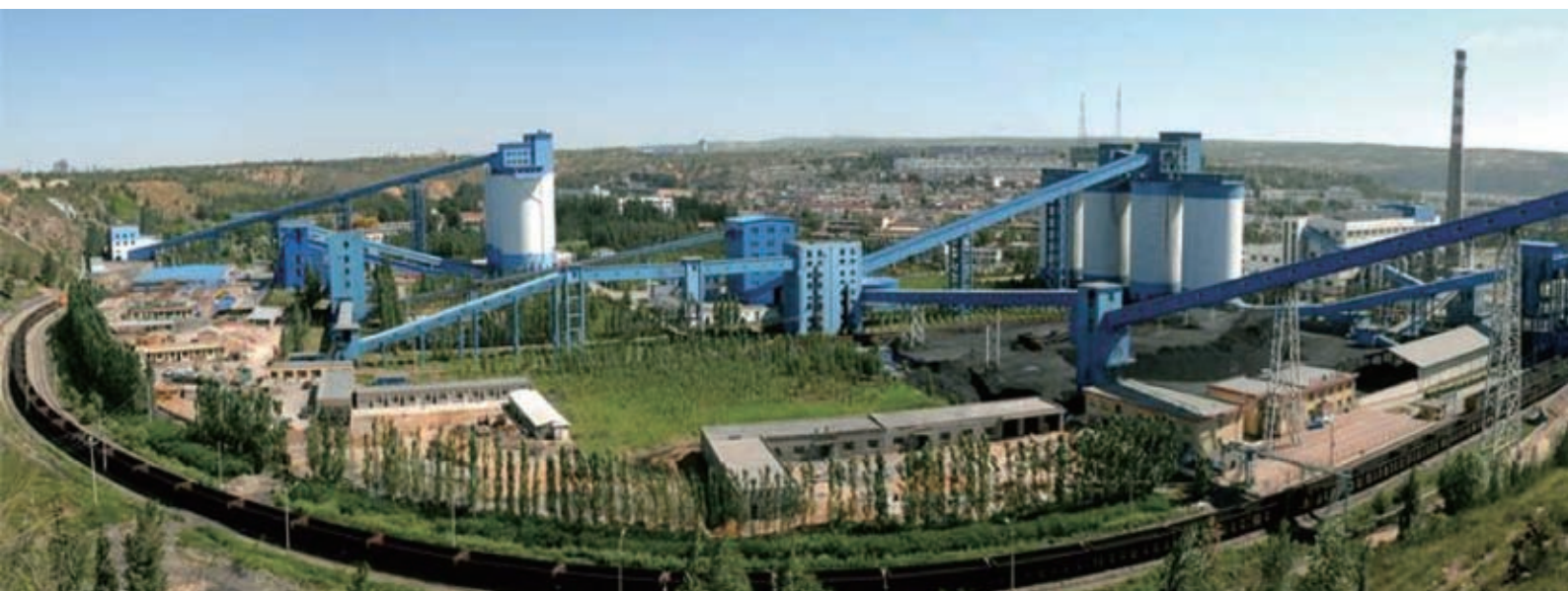
神東煤炭集團上灣煤礦外景
