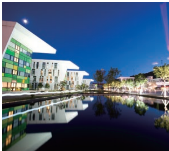
宁海电厂生活区
