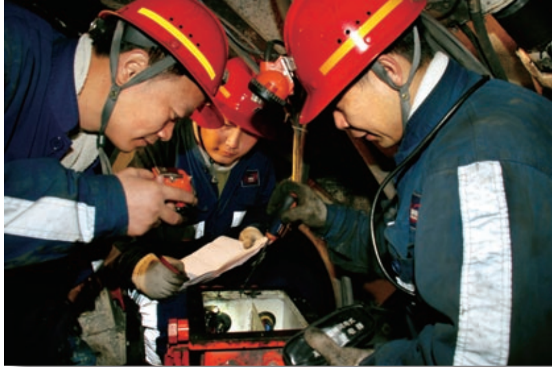
井下工人检测设备现场
