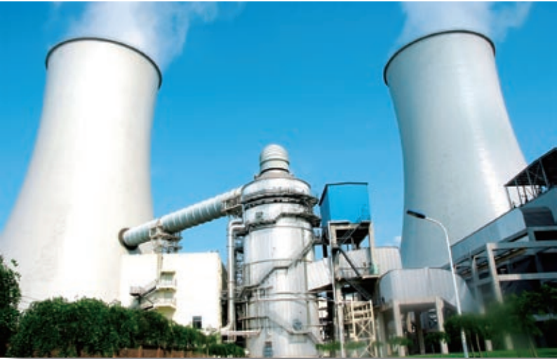
三河电厂应用烟塔合一技术脱硫装置
